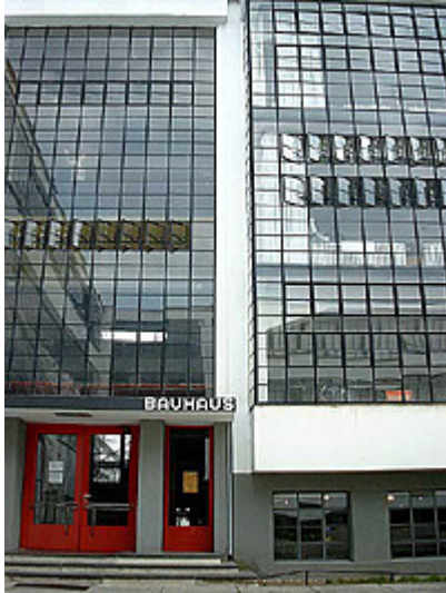
Ingang werkplaats bauhaus
